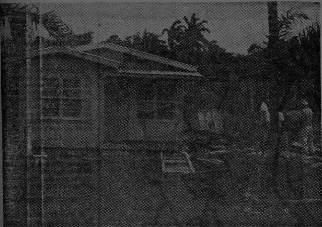
COLONOS DE PEJIVALLE construyen nuevas casas; En la gráfica, vemos al señor Miguel Vargas, propietario de la primera casa, ya construída, lista para ser habitada. También un grupo
